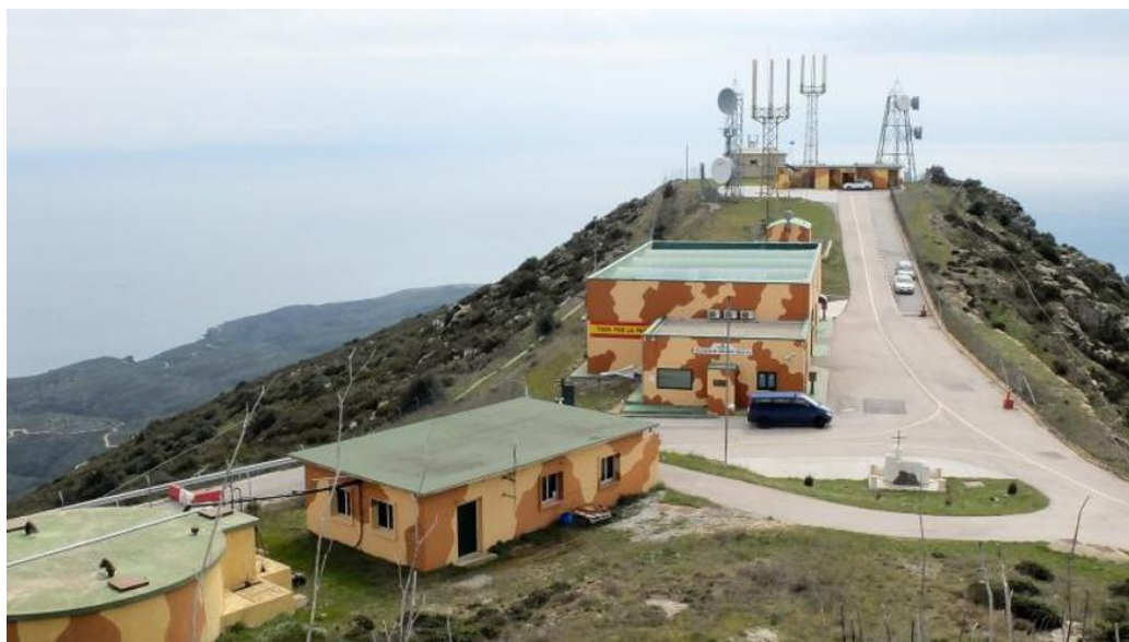
Vista actual del cim del Pení, amb les instal·lacions militars.
